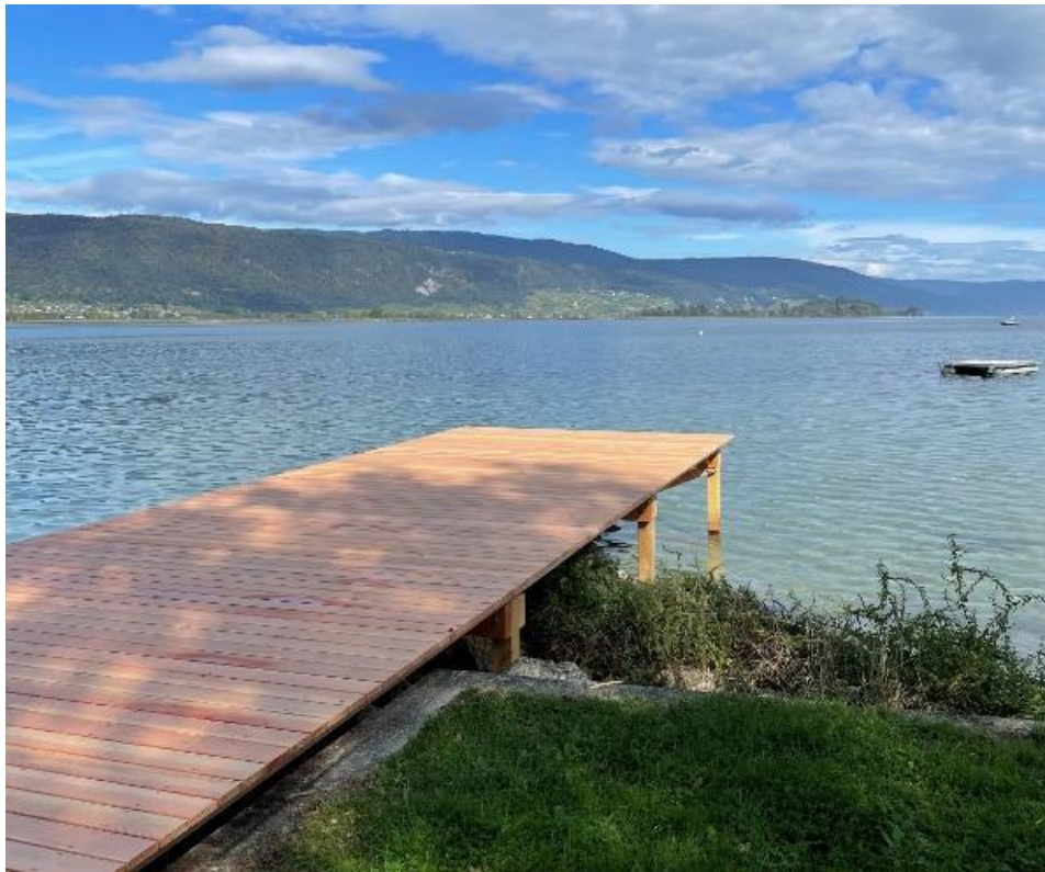
Der neu sanierte Badesteg
