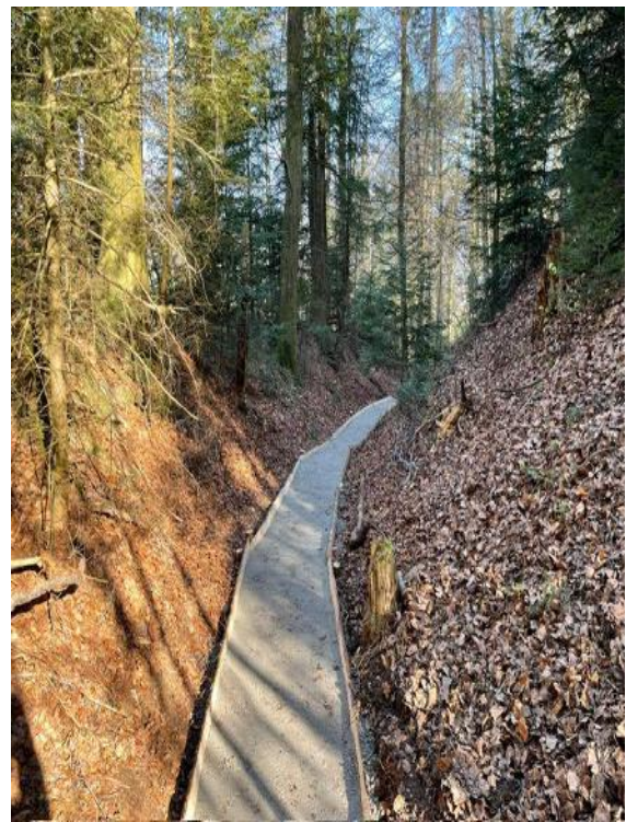
Der neue Zugangsweg von Vinelz her im oberen Bereich
