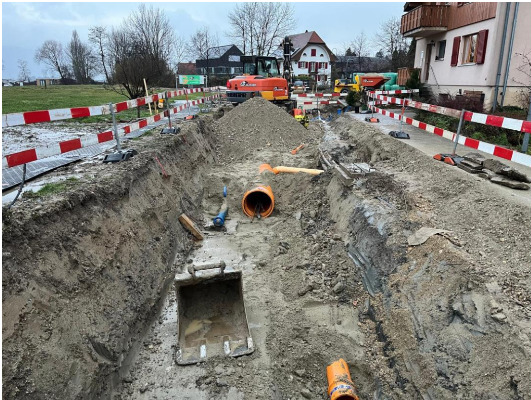
Sanierung Werkleitungen Gostel Februar 2025
