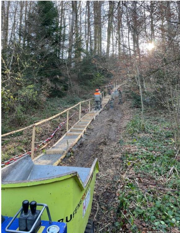
Der neue Zugangsweg von Vinelz her im unteren Bereich über Treppen
